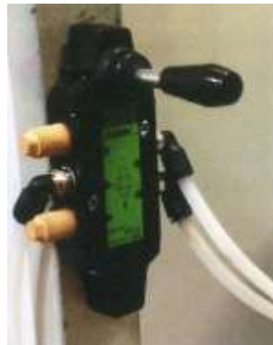
Figure 12 : Photographie de la commande pneumatique d'ouverture - fermeture des couvercles
