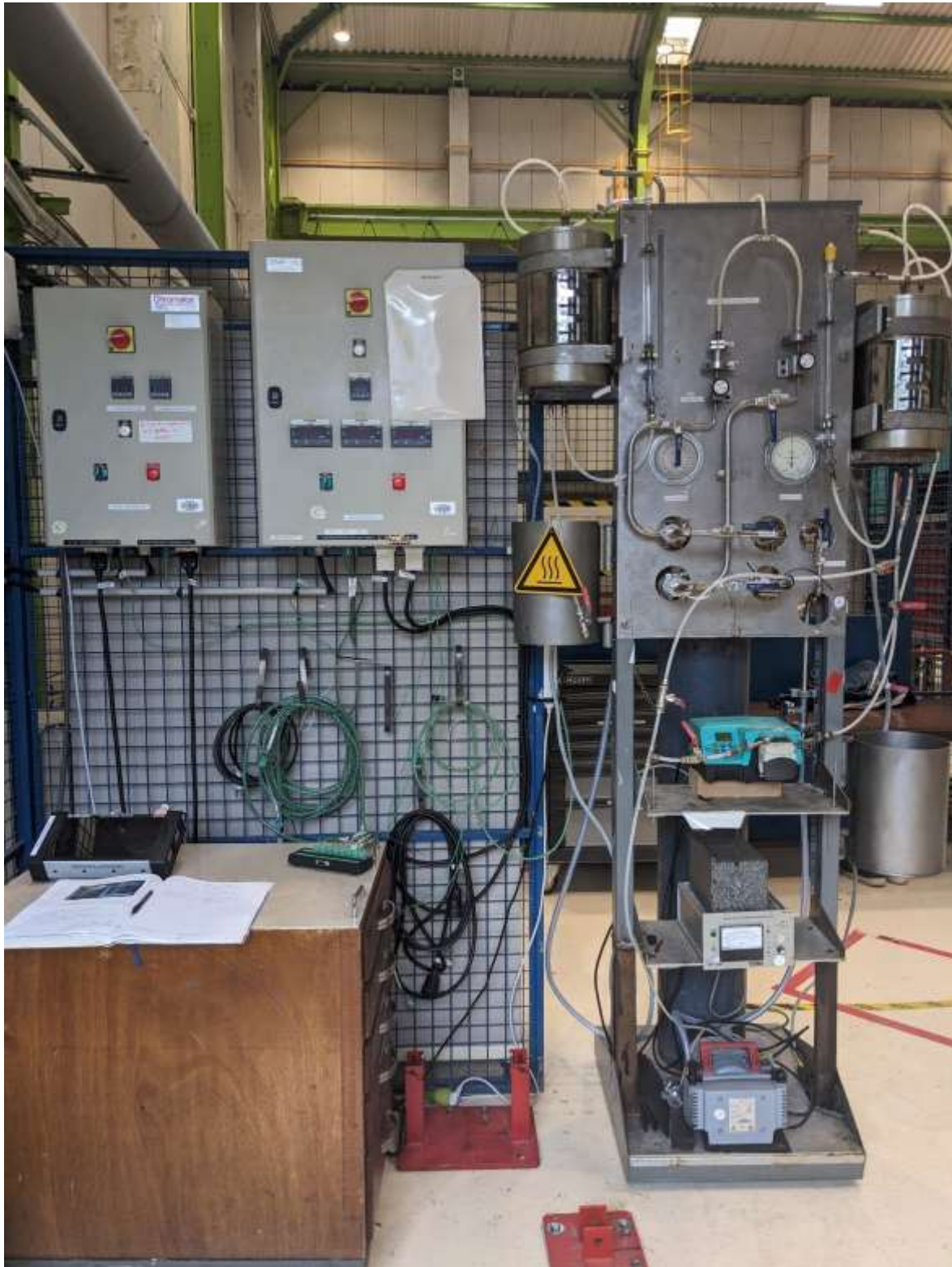
Figure 2 : Station d'imprégnation actuellement installée au bâtiment 122
